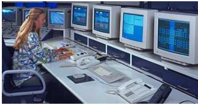
Figur 5.7: Kontrollrom i distribuert styringssystem
